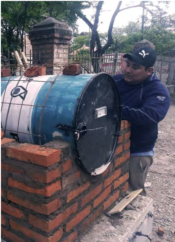
Imagen del desarrollo del taller: titulares y talleristas levantando los muros del horno y cocina de bajo consumo de leña.
