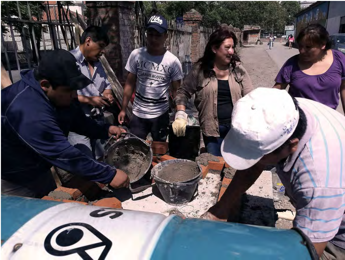
Imagen del desarrollo del taller: titulares y talleristas levantando los muros del horno y cocina de bajo consumo de leña.
