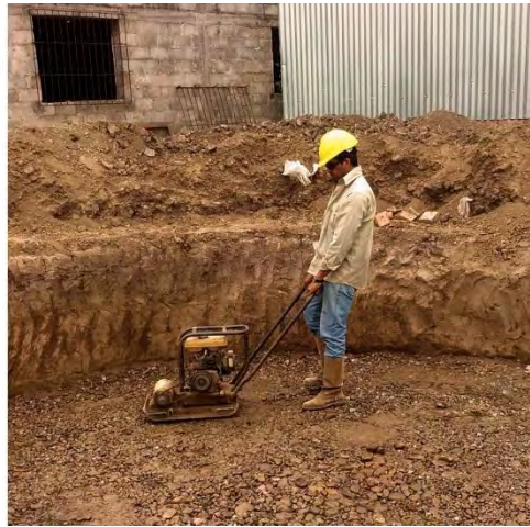
Cavado del pozo y compactación del terreno para el tanque cisterna.
