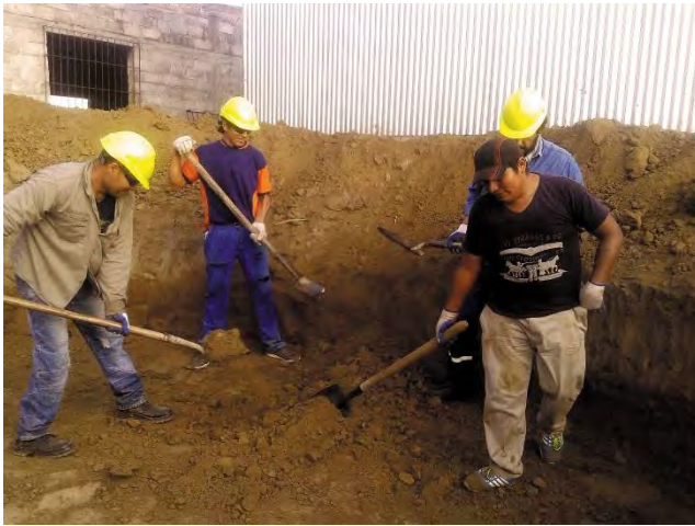
Cavado del pozo y compactación del terreno para el tanque cisterna.
