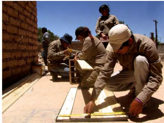
Imágenes del taller práctico: construcción de los cerramientos del deshidratador solar.
