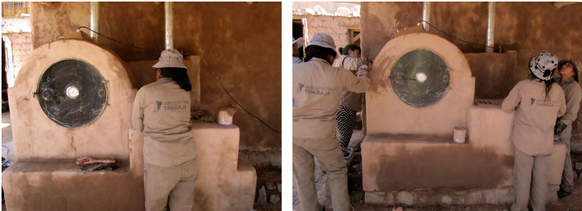
Construcción de tecnologías en base a sistemas de adobes y revoques de tierra para el aprovechamiento de sus condiciones de inercia y eficiencia térmica.
