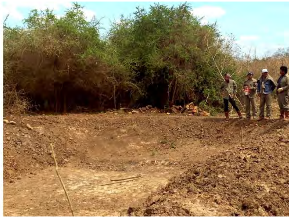
Trabajos manuales de movimiento de suelos, nivelado y terraplenado.
