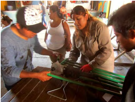
Imágenes del taller práctico: prácticas en el armado de cañerías termo fusionadas para el montaje del circuito de agua.
