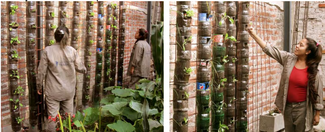
Titulares montando el sistema sobre un panel de malla CIMA rigidizado sobre columnas de perfiles. Para estas tareas se realizan interacciones con los titulares del taller de Mejoras de Espacio Socio-Comunitario.
