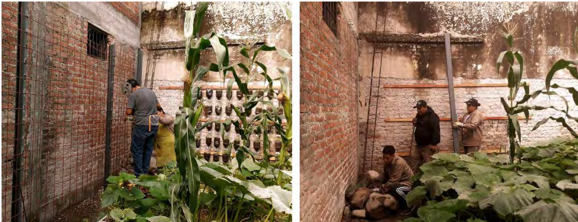
Titulares del taller de Mejoras de Espacio Socio-Comunitario colaborando en el montaje de estructuras para la huerta vertical.
