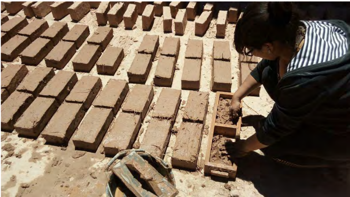
Fabricación de adobes de distintas dimensiones para la construcción de hornos de alto rendimiento (25 x 40 x 12cm y 12 x 26 x 6 cm).
