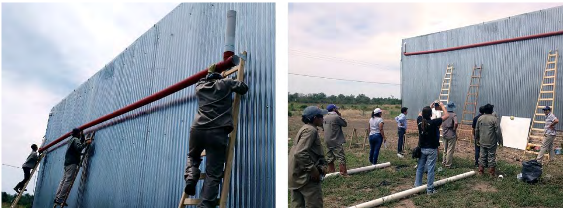
Colocación de las cañerías de desagüe pluvial para la captación de agua.
