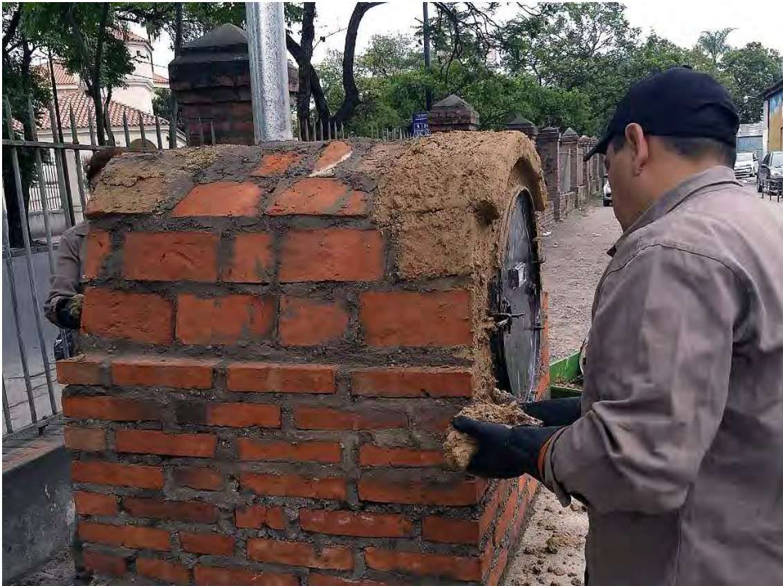
Imagen del desarrollo del taller: revoque de tierra y terminaciones finales de la tecnología.
