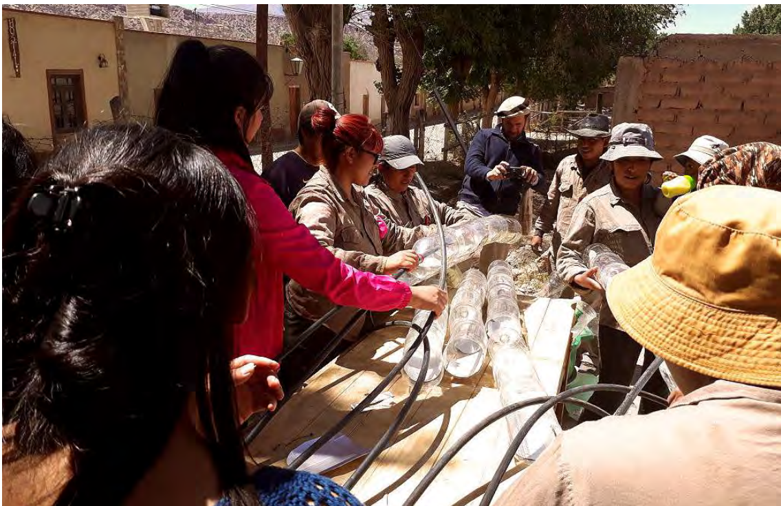
Imágenes del taller práctico: montaje del sistema de cañerías.
