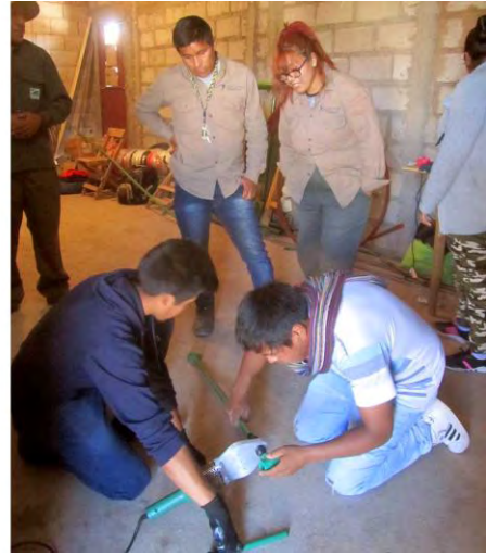
Imágenes del taller práctico: construcción del colector solar con sistema de cañerías termo-fusionadas.
