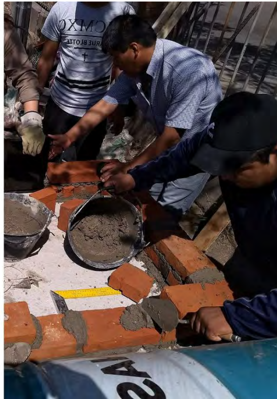
Imagen del desarrollo del taller: titulares y talleristas levantando los muros del horno y cocina de bajo consumo de leña.
