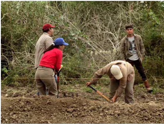
Trabajos manuales de movimiento de suelos, nivelado y terraplenado.
