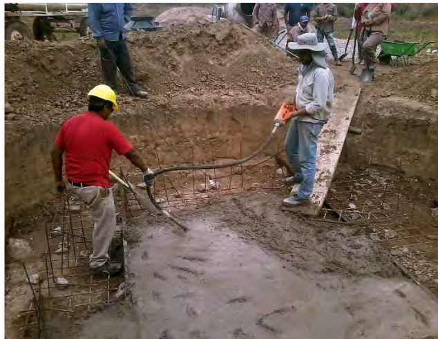
Cavado del pozo y compactación del terreno para el tanque cisterna.
