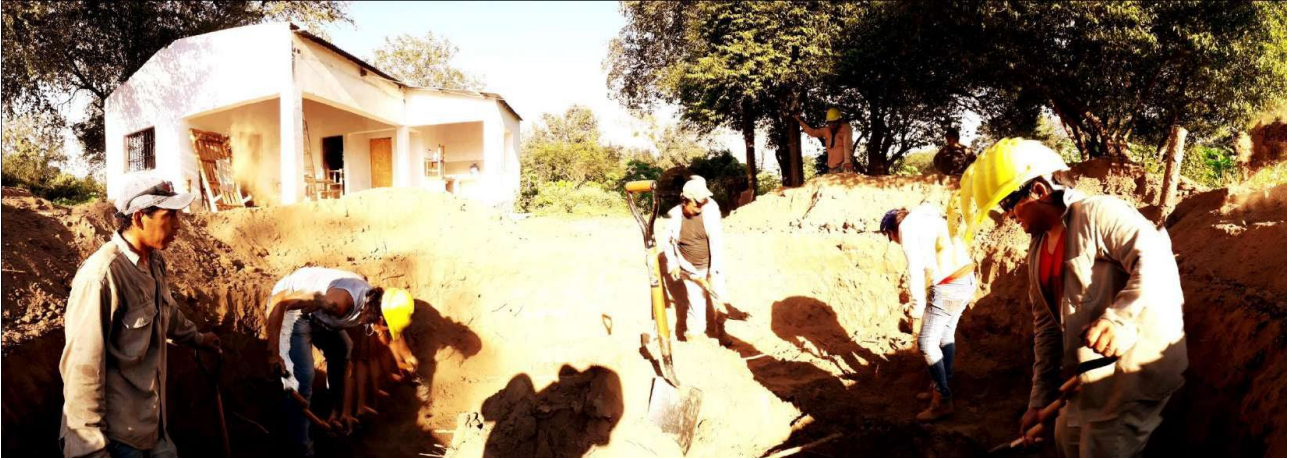
Tanque cisterna de 16.000 litros (sistema PLACA)
