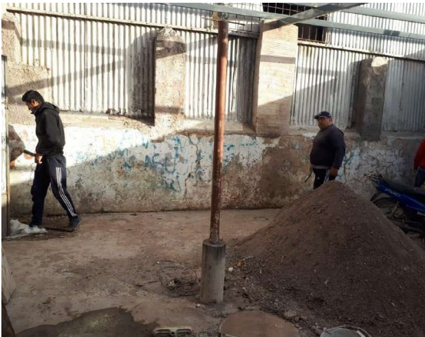
Antes de la intervención.
