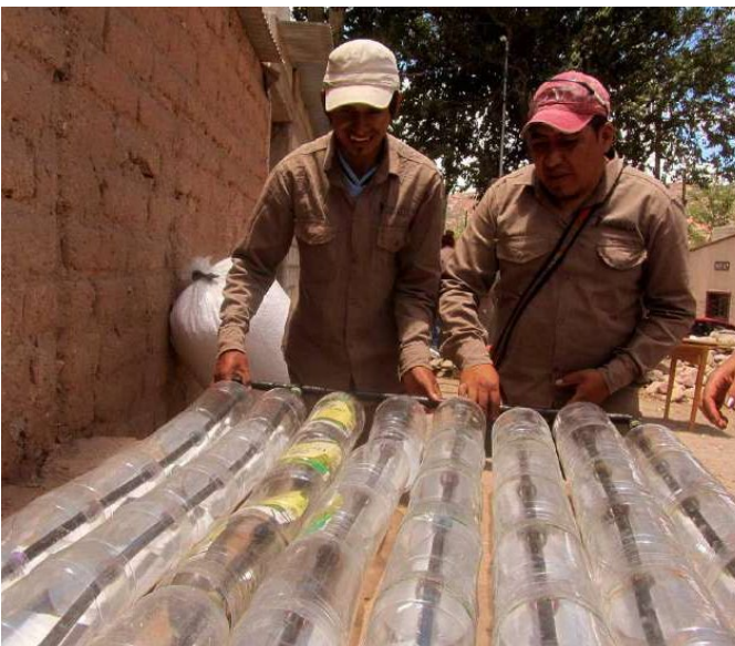
Calentador solar de agua con botellas de plástico
