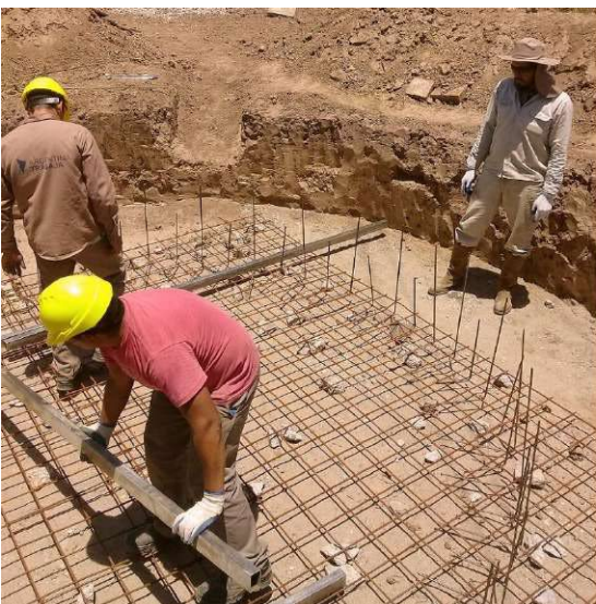
Trabajos de cavado de pozo, armado de losa, armado de malla CIMA, azotado cementico, armado y colocación de tapa.
