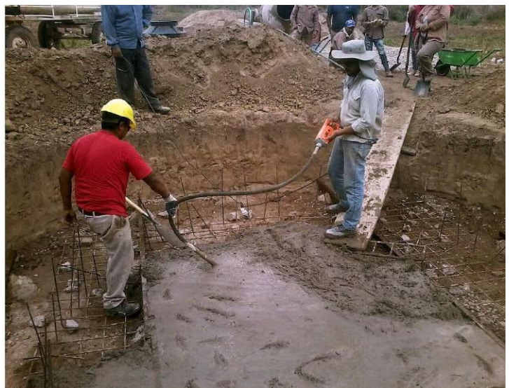
Trabajos de cavado de pozo, armado de losa, armado de malla CIMA, azotado cementico, armado y colocación de tapa.
