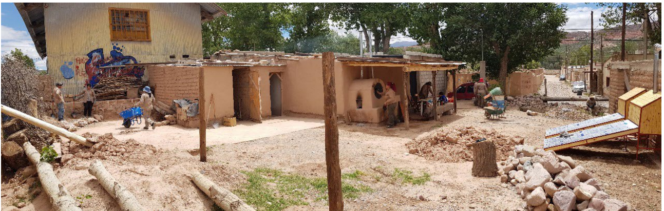
Después de la intervención
