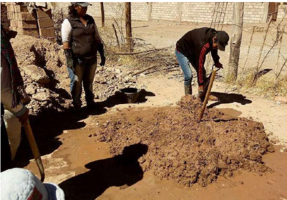
Fabricación de adobes de distintas dimensiones (25 x 40 x 12cm y 12 x 26 x 6 cm).
