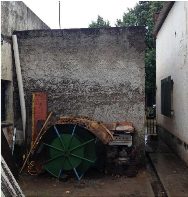
Antes de la intervención.
