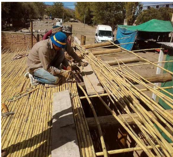
Atando las cañas para el cielorraso
