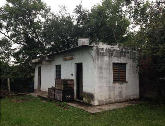
Antes de la intervención
