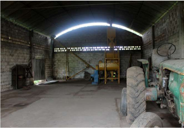
Antes de la intervención.
