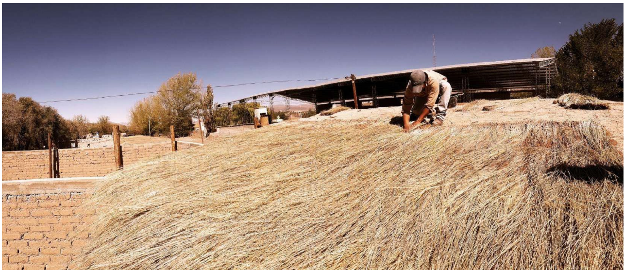
Construcción de un techo con técnica regional de guayado.
