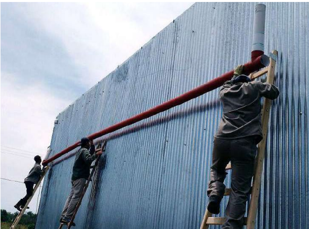
Tanque cisterna de 26.000 litros (sistema malla CIMA)
