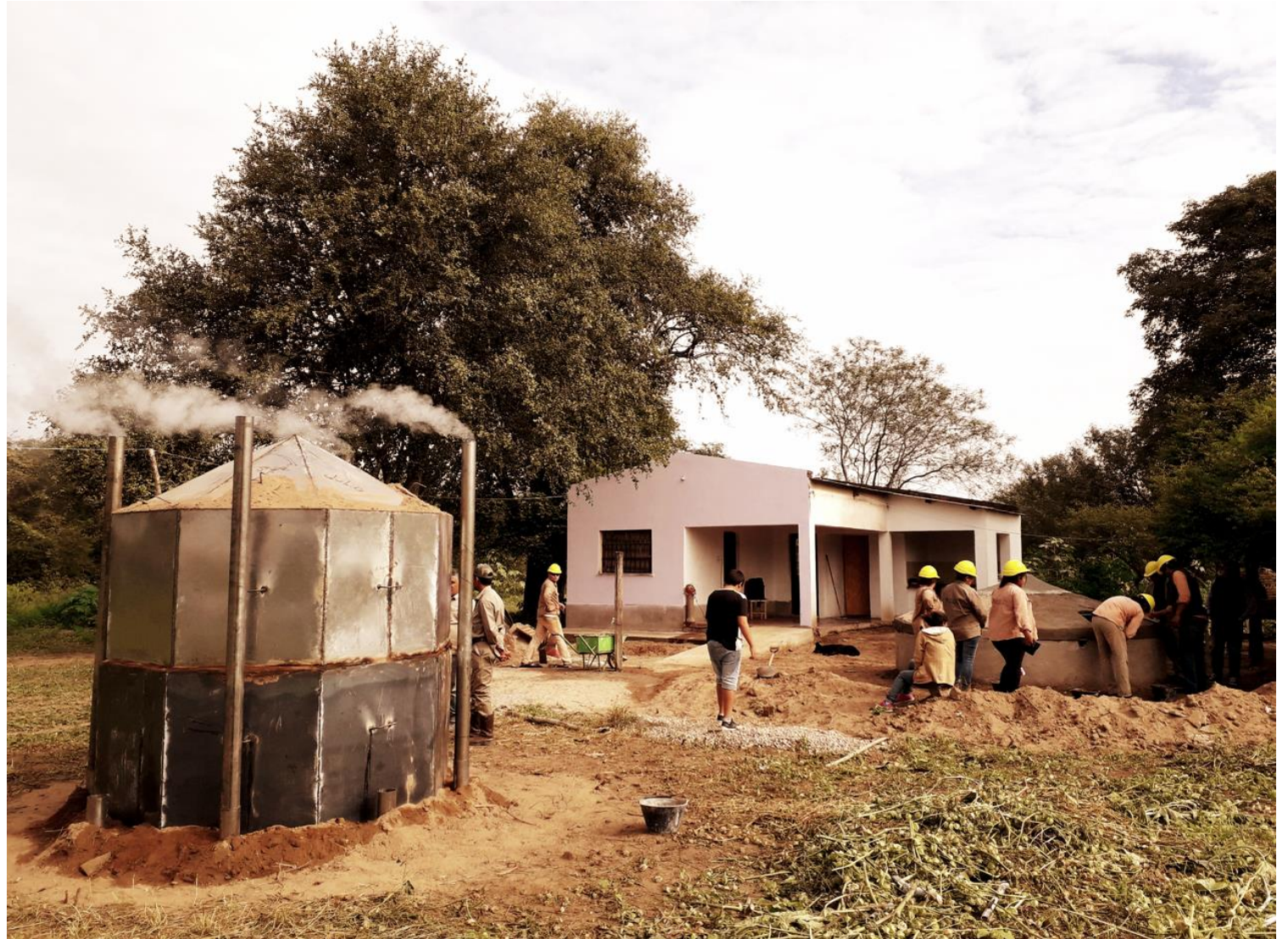
Hornos para carbón vegetal de alto rendimiento contruidos en talleres de capacitación en herrería por ACIDI y técnicos de CIMBRA.
